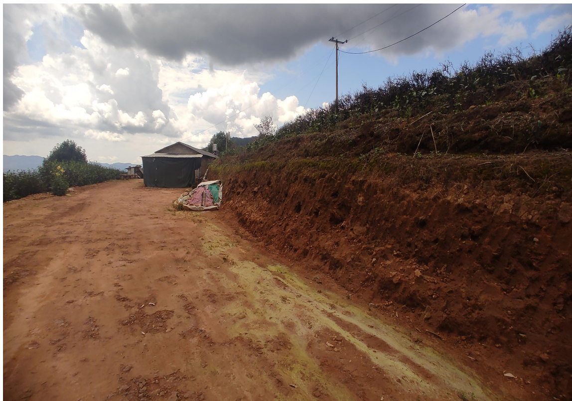
图 5 进出光伏电场道路
